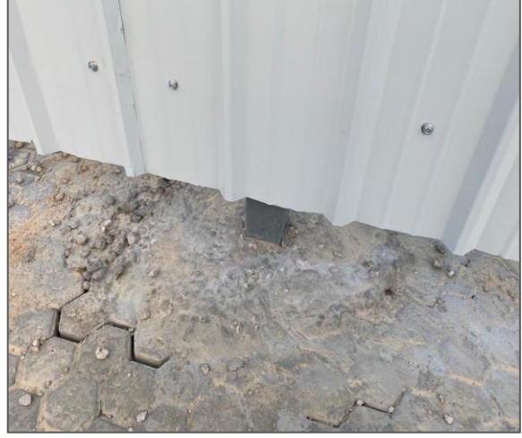
شكل رقم (9): تثبيت خاطئ لأعمدة السور المؤقت
